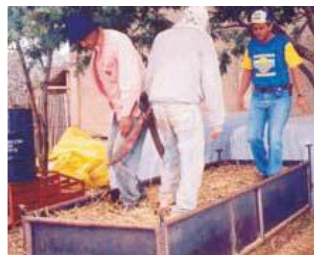
Fig. 4 – Compactação do material
